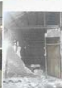
Kerusakan di Kampung Mayen Tg. Druak, Pantai Timur Bant, Sams
